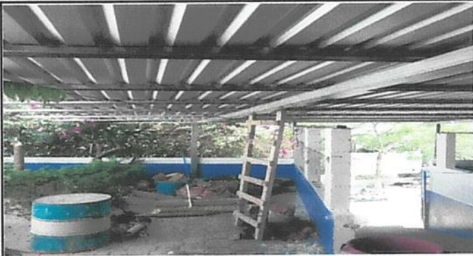
SUSTITUCIÓN DE LAMINA POR LAMINA TROQUELADA
