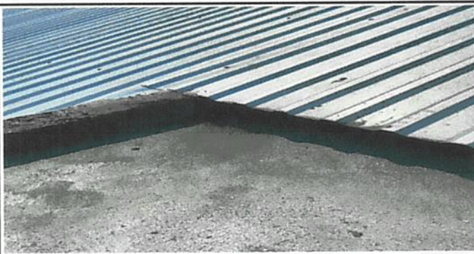
SUSTITUCIÓN CANAL DE METAL
