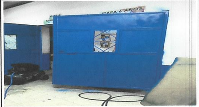
MANTENIMIENTO A ESTRUCTURA LIJADO DE TUBO CEPILLADO SUJECCIONES APLICA DE PINTURA
