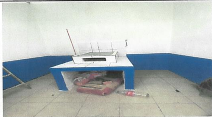
SUSTITUCIÓN DE LA ESTUFA RURAL INCLUYE CHIMENEA Y PLANCHA DE METAL
