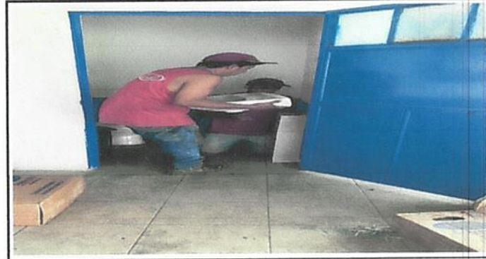
SUSTITUCIÓN DE LAVAMANOS
